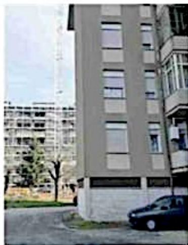
La palazzina di via Lama S1 passata adesso dal Comune di Rieti all'Ater
